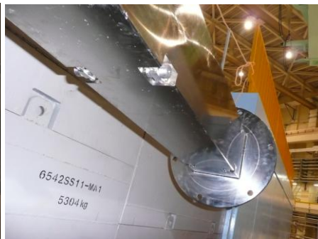
場所：日本原子力研究開発機構 品名：超高压中性子回折装置 生体遮蔽部埋め込み機器 (管理区域内据付作業中)
